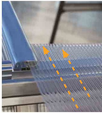
A táblákat egyszerűen rögzítették a kerületi profilokban.
