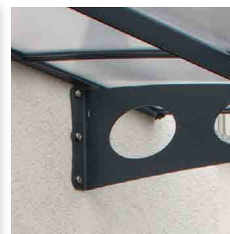
Horganyzott és lakozott acél merevítők
